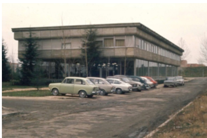
Imagen 2: Edificio del Centro de Cálculo
